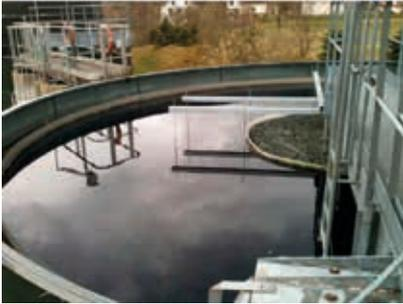
Le principe auquel Densiline s'est toujours tenu trouve, dans ce cas particulier, son application principale: la décantation assistée par les contre-courants générés par le Speed-O-Clar. Un ensemble de pompes de petit débit
