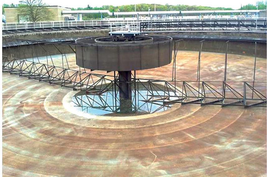
périphérique et un pont sucé. Ce type d'alimentation est particulièrement intéressante dans le cas où l'eau à traiter est fortement chargée et le diamètre du décanteur est petit. Le décanteur Unitube a la particularité de pouvoir aspirer la boue qui se dépose au fond du bassin. La hauteur d'eau permet l'écoulement de la boue dans le tube de collection.
