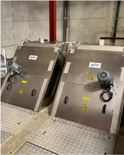
Le dégrilleur escalier DESC XXX est un équipement de prétraitement des eaux usées avant leur arrivée dans la station d'épuration. Conçu en acier inoxydable AISI 304L, il est constitué de deux groupes de lames, l'un fixe et l'autre mobile, également en acier inox 304L.
