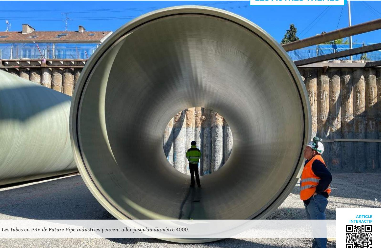
Les tubes en PRV de Future Pipe industries peuvent aller jusqu'au diamètre 4000.
