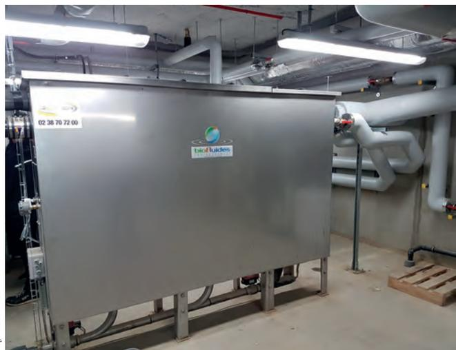
L'unité ERS couplée aux panneaux solaires thermiques installés sur le toit du lycée, couvre 100 % des besoins en eaux chaudes sanitaires des 110 chambres des internes, de l'infirmerie et des points d'eau du lycée.
