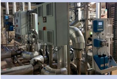
Ce moniteur est constitué d'un système complet pour la mesure, avec transmetteur, photomètre, chambre d'analyse, détecteur de débit, réactifs pour le dosage de l'ozone, l'ensemble étant assemblé sur une panoplie inox.
