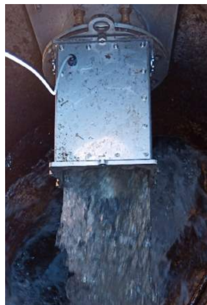
Le débitmètre hydraulique Graviflow s'intègre dans les ouvrages existants sans contraintes d'installation – sans longueurs droites amont et aval imposées, par exemple – ni travaux de génie civil.
