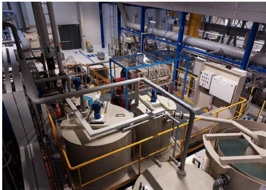
Station physico-chimique, évaporateur et cuve de stockage d'eau recyclée en industrie du traitement de surface. Réalisation AQUAPROX I-Tech.
