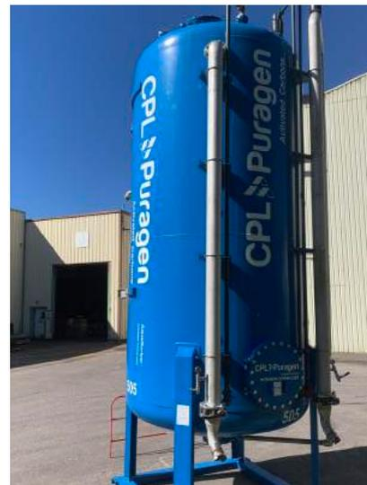
Clean-flo® Aquasorber® 22 -100 avec 22 m<sup>3</sup> de Charbons Actifs en Grains pour recyclage en sortie de station d'épuration industrielle.
