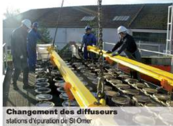
Changement des diffuseurs stations d'épuration de St Omer
