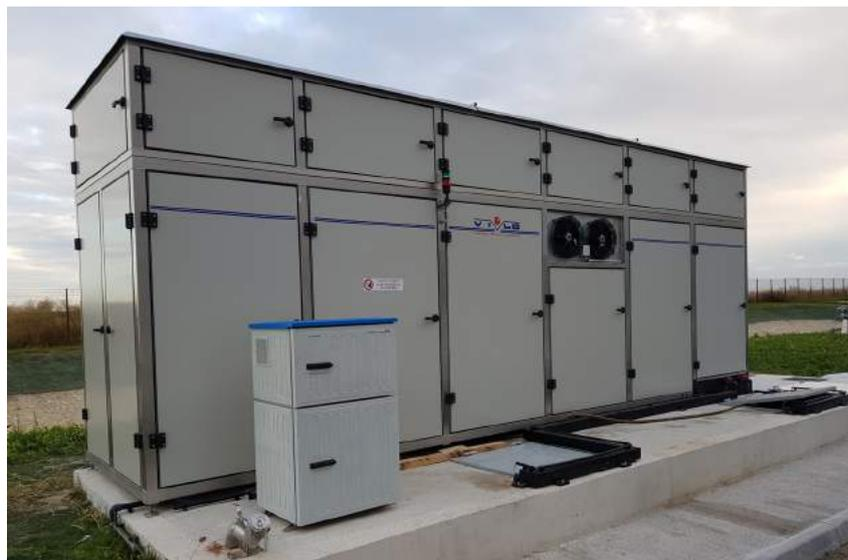
Installation Zéro Rejet Liquide de la société Vivlo. Évaporateur sous vide basse température en container intégrant un post traitement par Bioréacteur à Membrane. Capacité de 1 m<sup>3</sup>/h sur un site d'entretien de matériel ferroviaire.
