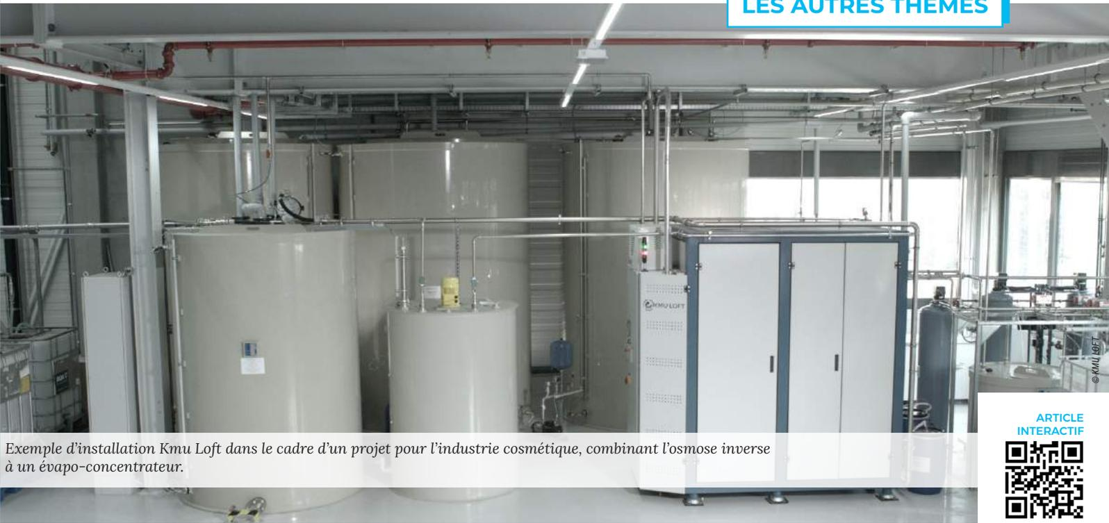
Exemple d'installation Kmu Loft dans le cadre d'un projet pour l'industrie cosmétique, combinant l'osmose inverse à un évapo-concentrateur.
