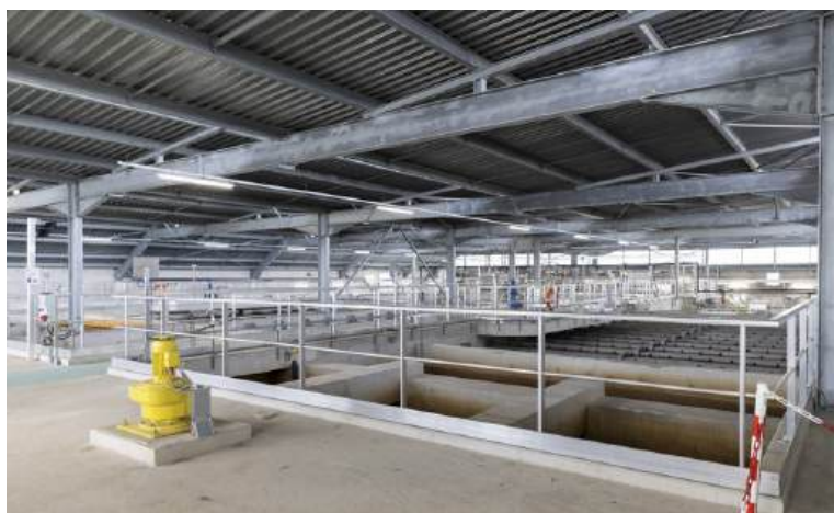
L'usine d'Orly 2 (Eau de Paris).
