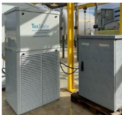
Préleveur piloté par la station de biosurveillance ToxMate sur la STEP de Chartres Métropole Assainissement, gérée par Aqualter.
