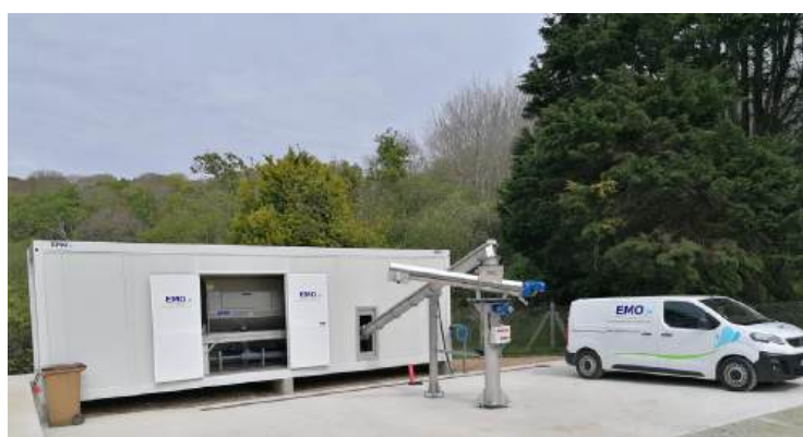
Unité de déshydratation de boues en abri modulaire PRESSE À VIS
