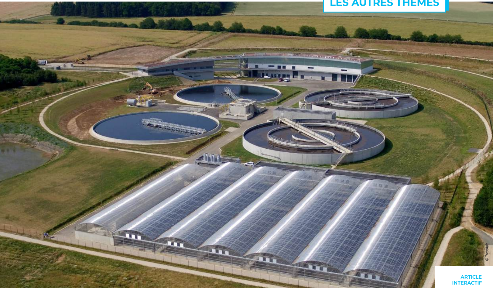
Sécheur solaire Tersolair - Station d'épuration de Chartres.
