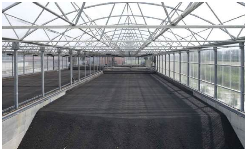
Double serre de séchage solaire équipé de ponts retourneurs Huber, en fonctionnement depuis 2009 sur la STEP de Gunstett (67).
