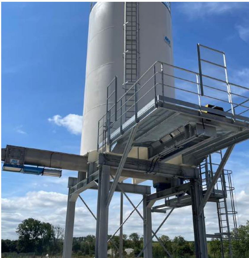
Silo Akis cadre coulissant, solution pour le stockage de boues déshydratées. Akis propose également un système complet de déshydratation des boues par une presse à vis et son transport par convoyeur à vis.
