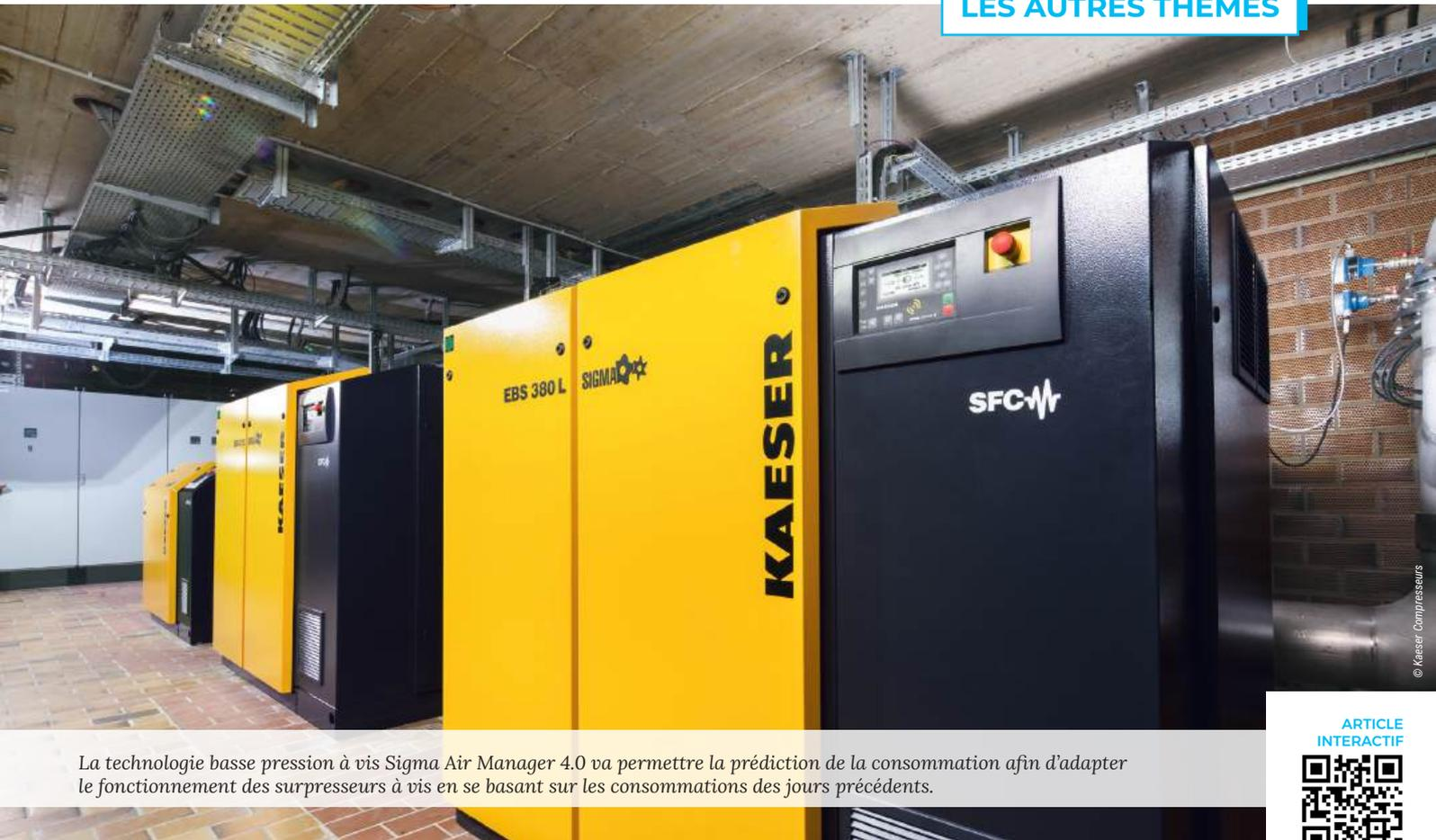
La technologie basse pression à vis Sigma Air Manager 4.0 va permettre la prédiction de la consommation afin d'adapter le fonctionnement des surpresseurs à vis en se basant sur les consommations des jours précédents.
