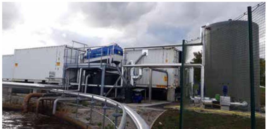
Unité REUT d'eau de station d'épuration en appoint des TAR, conçue et fabriquée par Aquaprox I-Tech pour une IAA française.
