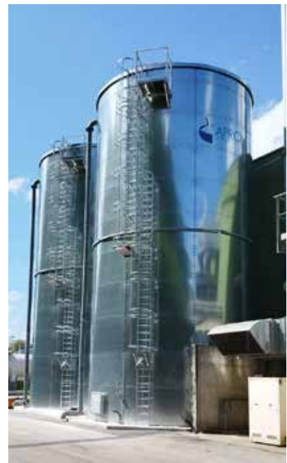
Réserveurs Apro Industrie stockant des eaux de REUSE.
