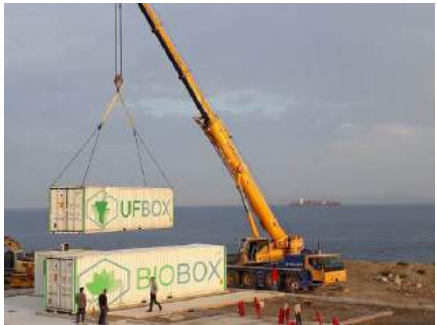
Module Biobox de la société Flau, adapté aux zones touristiques à variation de charge saisonnière, ici en cours d'installation dans une zone balnéaire.
