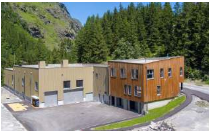
La station d'épuration de Tignes les Brévières, où OTV a mis en place un système de traitement adapté aux variations saisonnières.
