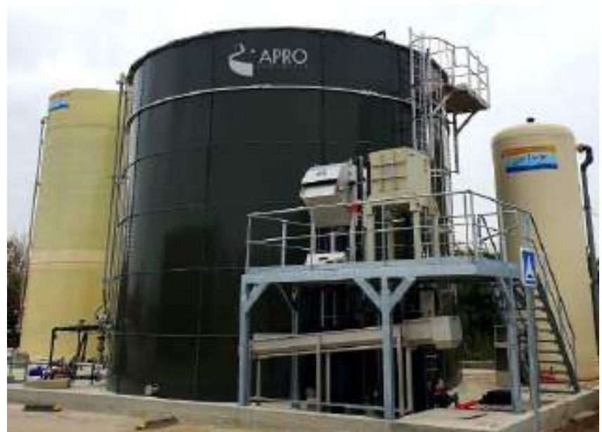
Bassin tampon de 500 m 3 en acier vitrifié, par Apro Industrie.
