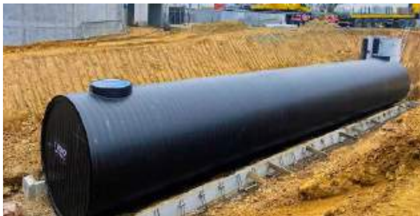
Bassin de stockage restitution (BSR) Tubatec installé pour la STEP de Rospez (22).
