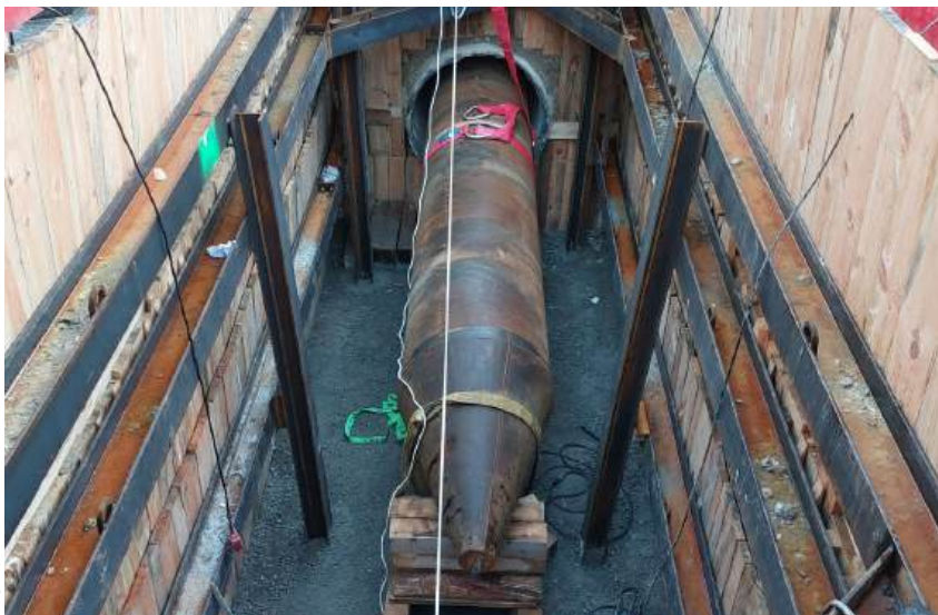
Tubage en 6x300 ml réalisé sur un chantier du Grand Paris, grâce à la technique sans tranchée et au matériel fourni par Aquarex Équipement.
