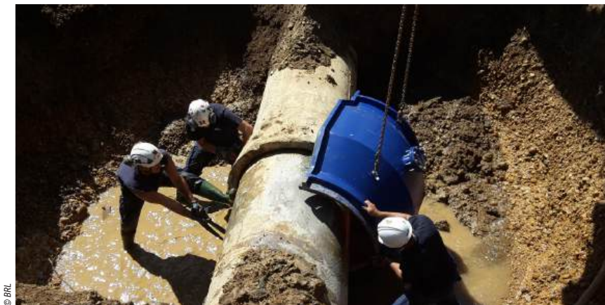
Les réparations au niveau des joints peuvent se faire par l'extérieur, par la mise en place de manchons. Une intervention qui impose des terrassements importants pour les équipes de BRL Exploitation.
