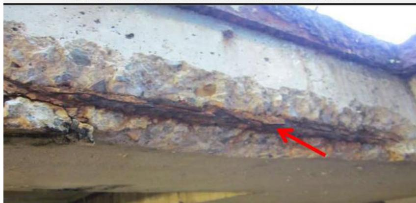
Photo 1: Dégradation par l'H<sub>2</sub>S et l'humidité de l'infrastructure béton armé sur le poste de relevage traité au nitrate de calcium.
