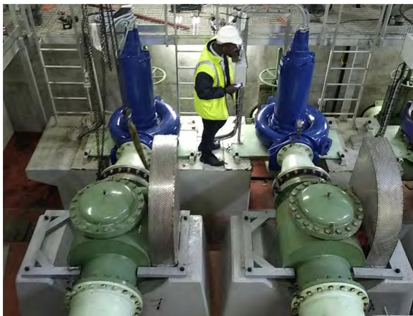
Poste de relevage rénové en 2018 avec des pompes Hydrostal de 45 kW munies de variateurs.
