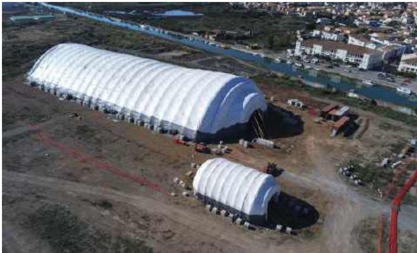
La tente de dépollution de 120 mètres par 50 mètres déplacée latéralement par un système de treuils sur le chantier mené par Sèché Eco Services à Frontignan (34).
