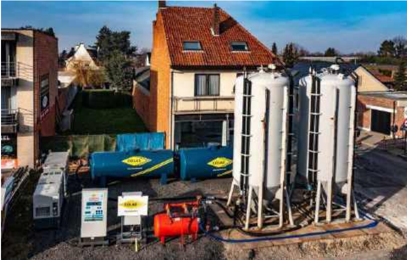
Travaux de pompage et traitement d'eaux impactées en PFAS, réalisés par Colas Environnement.
