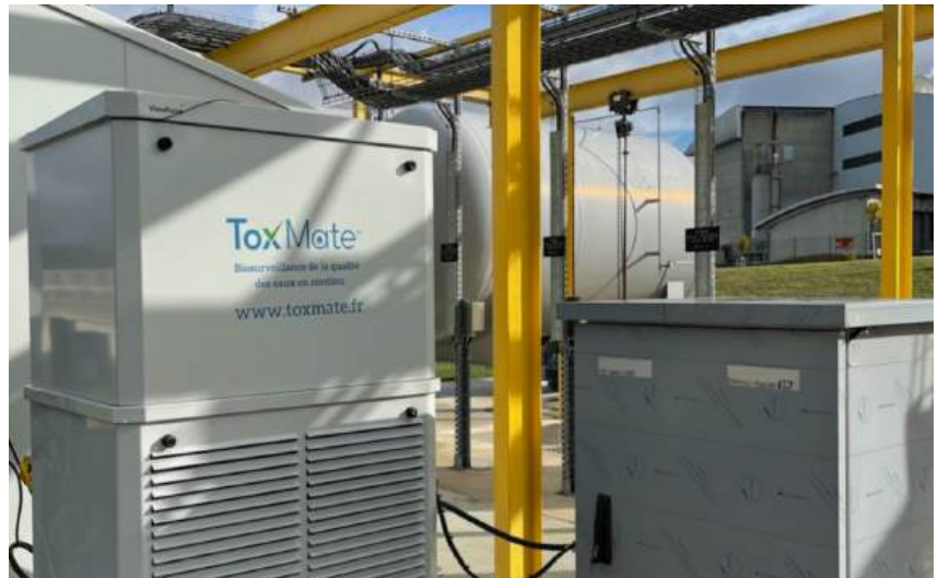
La station de biosurveillance ToxMate en Step urbaine, couplée à un préleveur (en option).
