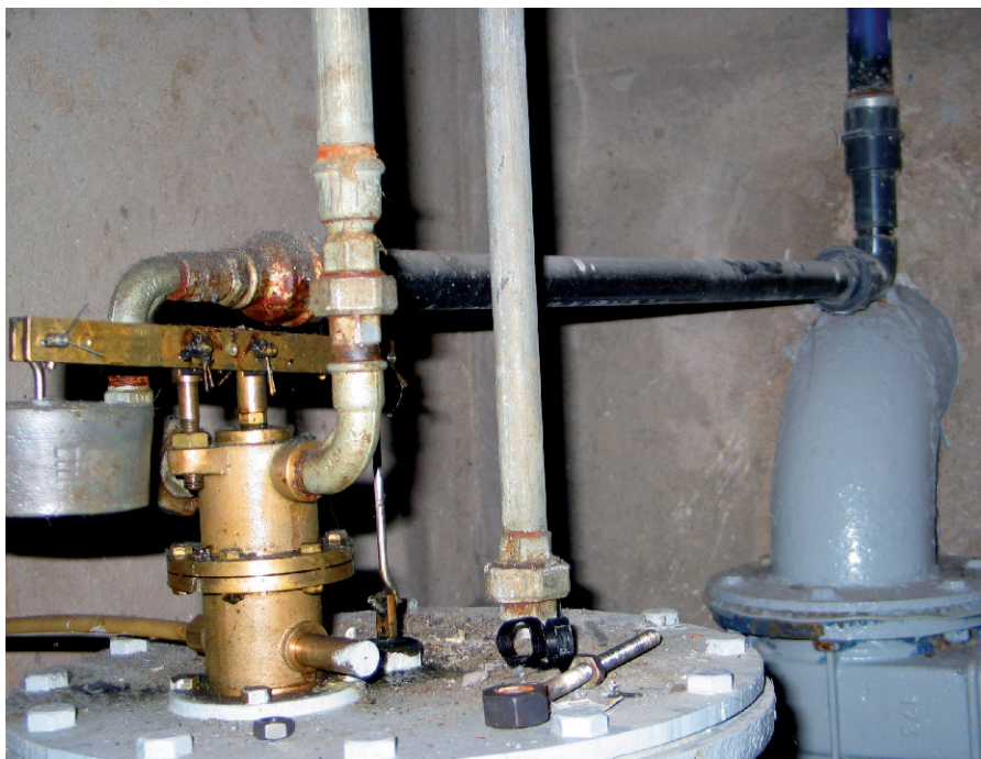
Toujours tout en fonte avec un distributeur en bronze et des accessoires en laiton ou en inox, l'aéroéjecteur de type « F » reste encore aujourd'hui présent au sein de la gamme qui s'est simplement élargie au fil du temps.
