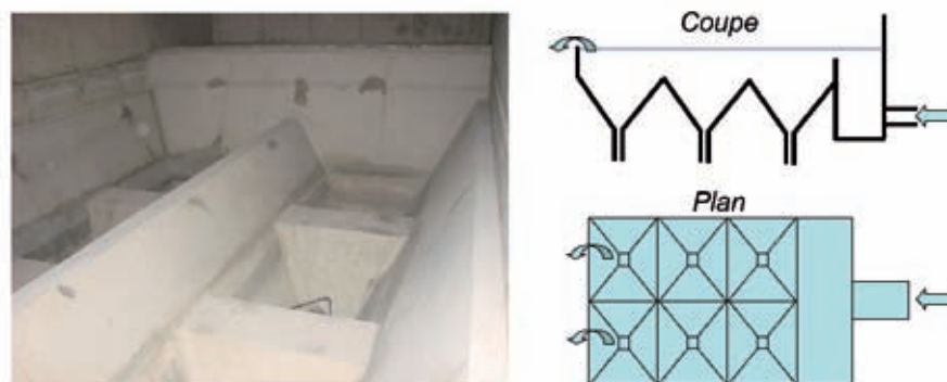
Figure 5 : Décanteur à six trémies pour la récupération des grains de biolite (photographie et schéma de principe).
