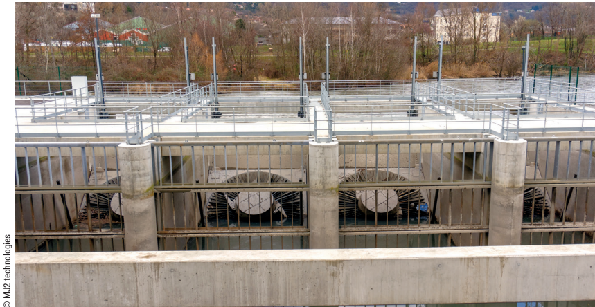
Turbines VLH en service sur la centrale du Rondeau à Échirolles
