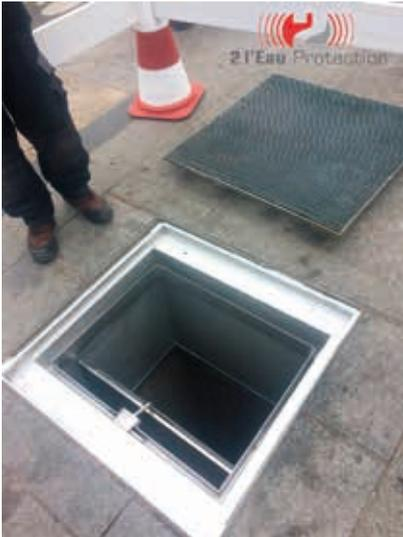
Les Trapao sont des trappes conçues par 2 L'Eau Protection pour protéger automatiquement les réseaux enterrés nécessitant des regards ou puits de ventilation. Les trappes sont installées au niveau de ces puits.
