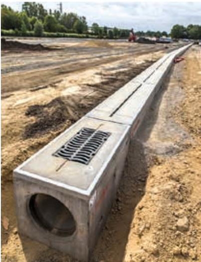
Le CF Forte® est un caniveau hydraulique à fente de type I (selon la norme NF EN 1433) qui permet la collecte des eaux de ruissellement sur des zones de circulation à très fortes contraintes de poids, de fréquence de circulation, de freinage, de giration. La capacité du CF Forte® à encaisser les chocs, les efforts et le poinçonnement garantissent à la fois la pérennité des ouvrages et la réduction des pertes d'exploitation dues à la maintenance ou au SAV des équipements.
