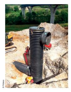
Grâce à son atelier de chaudronnerie plastique installé dans l'usine de Feillens, Polieco France a pu proposer à l'entreprise de pose une offre réseau complète avec des regards de grandes dimensions, tous réalisés sur mesure.
