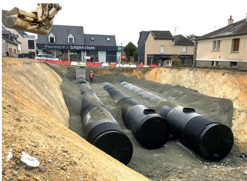
Le tube SGK en PEHD permet une installation des canalisations enterrées fiable et efficace.
