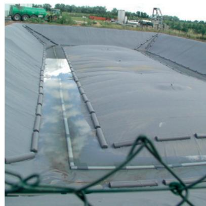
**C'est un système de stockage simple à installer, avec un faible impact environnemental. Il est entièrement "déconstructible" et les membranes RENOLIT ALKORPLAN sont recyclables via notre plateforme de recyclage ROOFCOLLECT. ([www.roofcollect.com](http://www.roofcollect.com))**
