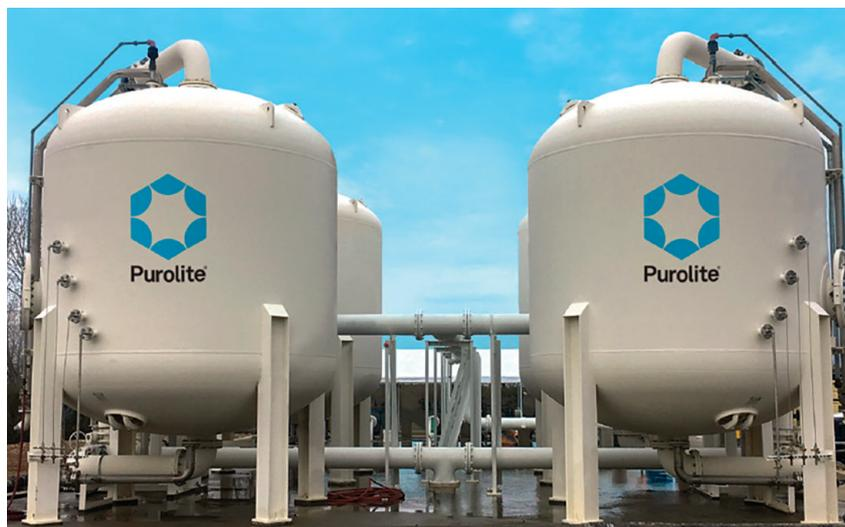
développée afin qu'elles soient sélectives des PFAs. La fixation des PFAs est réalisée par adsorption et échange d'ions permettant des capacités de fixation importantes et une réduction de la concentration en PFAs inférieure au ppb.
