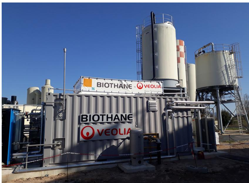
La technologie membranaire MemGas™ permet de purifier le biogaz en biométhane afin d'être conforme aux qualités requises pour son utilisation finale. Les membranes sont utilisées pour séparer les composés de méthane et de dioxyde de carbone afin de concentrer le méthane en biométhane. Celui-ci peut ensuite être injecté dans le réseau de gaz pour usage domestique ou industriel.
