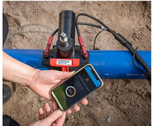
la vanne peut être équipée d'une extension de manœuvre selon les besoins de l'installation. La traçabilité est assurée par un code à barres pour un suivi précis du protocole de soudage.
