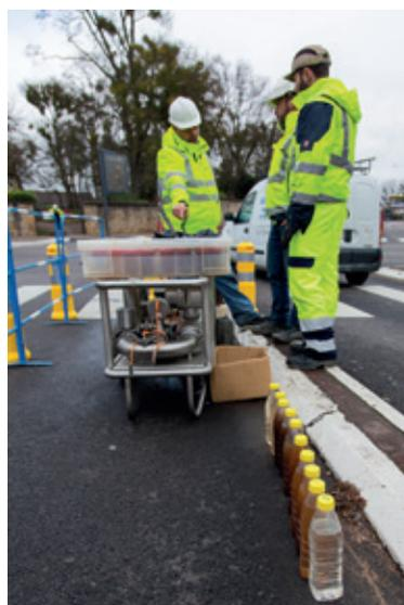
**L'Ice Pigging repose sur les propriétés décapantes et tranchantes d'un coulis de glace pompé dans une canalisation. Grâce à la pression, il élimine les dépôts et laisse les parois du tuyau propre et sans obstruction.**
