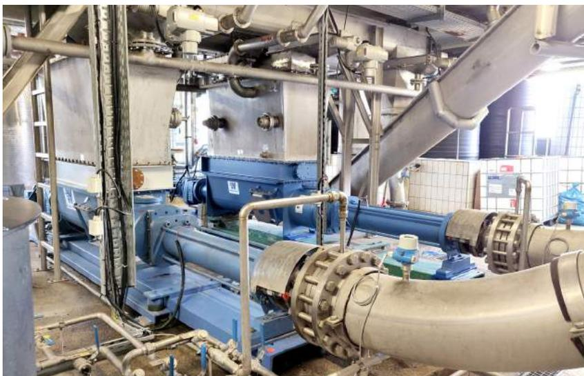
Pompes WANGEN pour traitement des boues dépurations, WANGEN Triplex.
