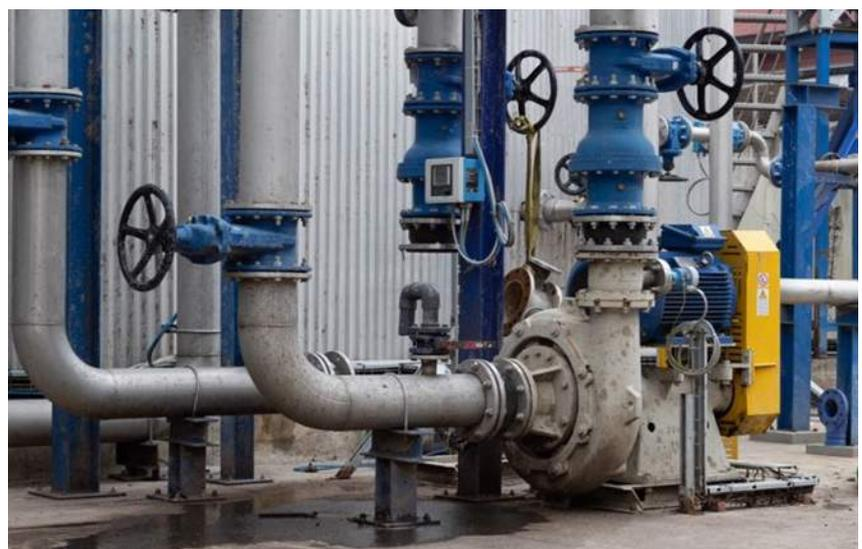
Les pompes PEMO peuvent être utilisées dans les stations de traitement des eaux usées municipales. Pour cette application, la pompe horizontale AO/TD est recommandée. Après le traitement des boues primaires et secondaires, ces dernières sont pompées vers les digesteurs anaérobies. Dans ces digesteurs, les micro-organismes décomposent la matière organique en absence d'oxygène, produisant du biogaz.
