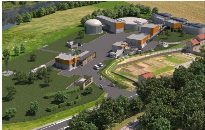
La future STEP de Chadrac au Puy en Velay (43), réalisée par Sources, d'une capacité de 75 000 EH, et combinant les boues granulaires avec une méthanisation des boues et réinjection du biométhane produit.
