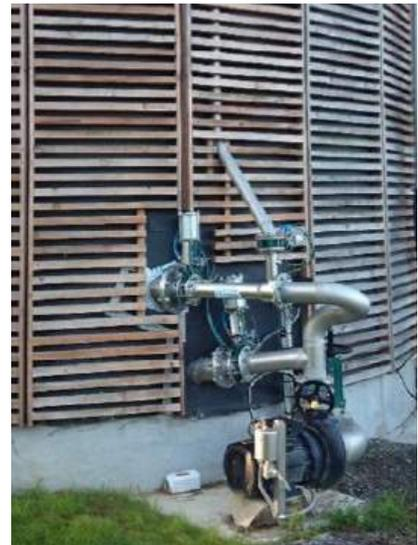
Le système Landia GasMix utilisé pour une station d'épuration en Bretagne, exploitée par la société SAUR.
