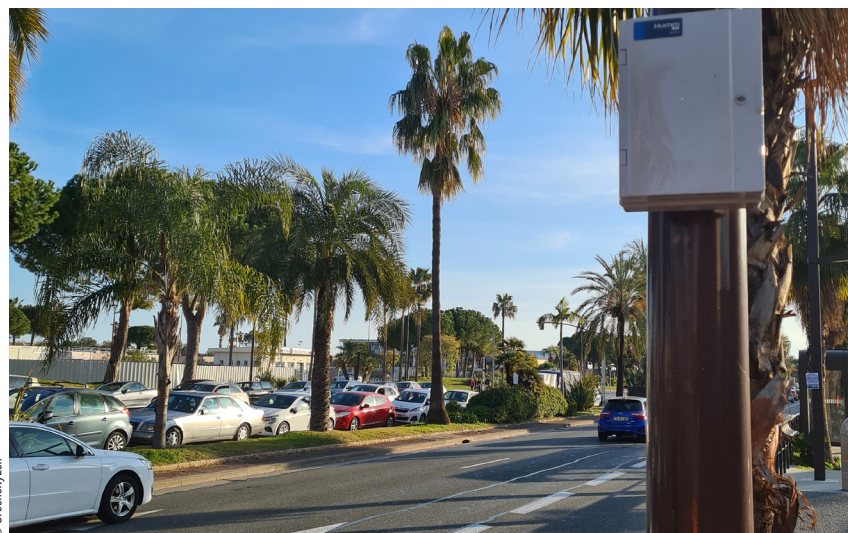
Greencityzen a mis la promenade des Anglais à Nice sous monitoring en continu de l'H 2 S en installant une vingtaine de capteurs qui permettent de contrôler le bon fonctionnement de la station d'épuration Haliotis située dans la ville.
