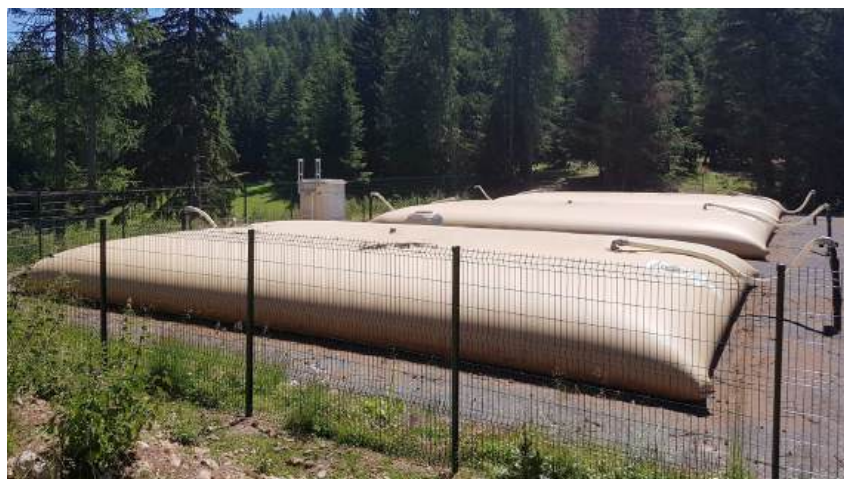
Les citernes souples sur-mesure conçues par Labaronne-Citaf sont réalisées à partir de tissus techniques adaptés en fonction du type de stockage.
