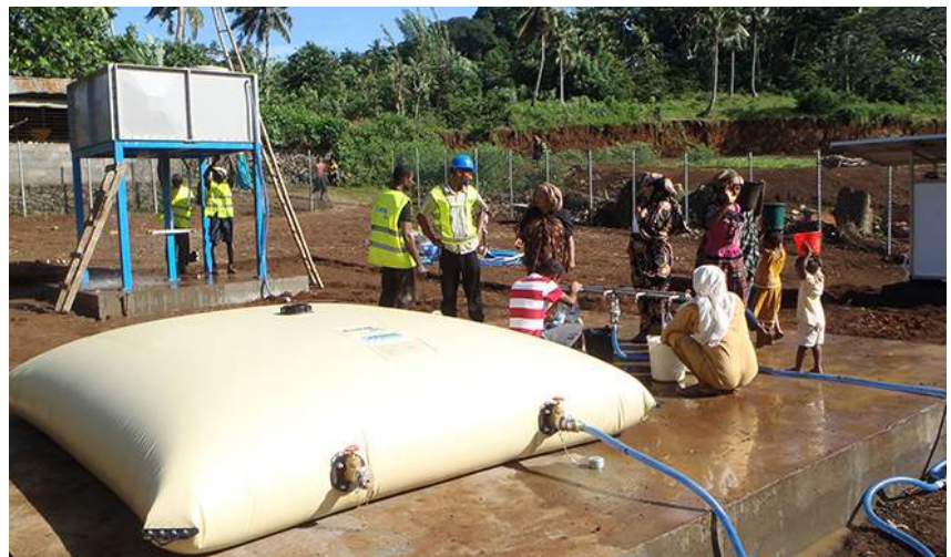
Citerne souple Pronal pour le stockage de l'eau potable, d'une contenance de 10m 3 .
